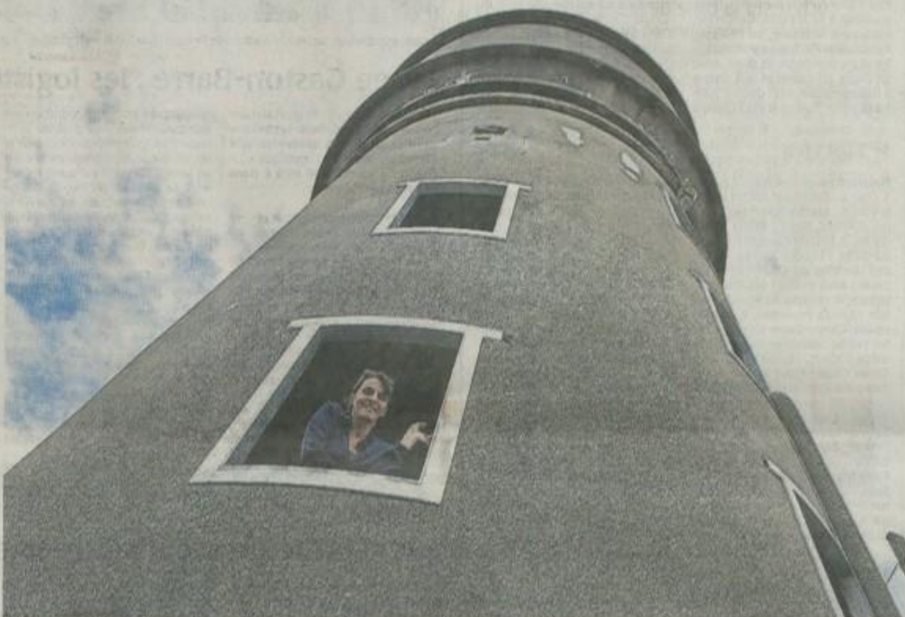
Niort, mercredi 14 septembre. La propriétaire, Rozenn Devic-Roussel, profite déjà des fenêtres dont vient de se parer son château d'eau. Photo CO - Benoît FELACE.
